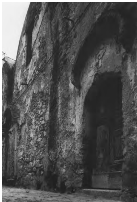
22. Chiesa di San Giovanni Battista della Porta, l’esterno prima del restauro.
